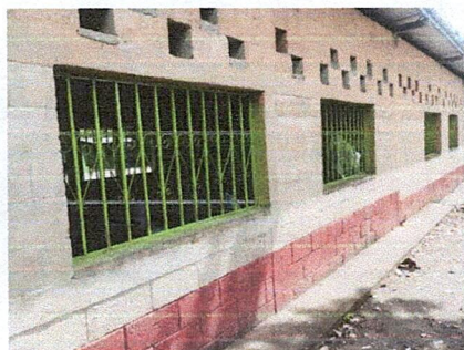
1. Mantenimiento a balcones de metal 1.00 x 1.60 (lijado, cepillado, aplicación de pintura anticorrosiva)
