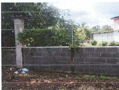
3. Suministro de block para circulación de muro perimetral (incluye columnas de 0.15 x 0.15 x 1.00 mt con hierro Ø 1/2" est. 1/4 + solera de 0.20 x 0.15 con hierro Ø 3/8" est. 1/4")
