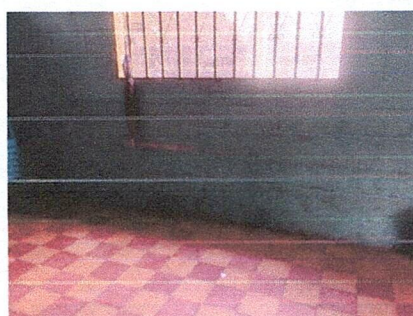
2. Sustitución de piso de granito por piso cerámico
