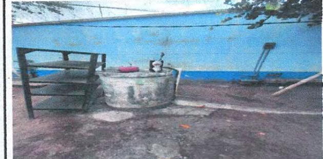
3.6 Sustitución de bomba eléctrica periférica de 1HP
