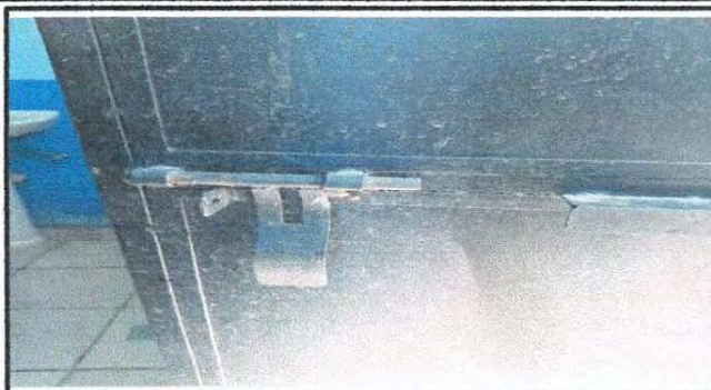
1.4 Suministro de chapa para puertas
