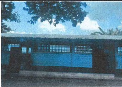
1.5 Sustitución de lámina a lámina troquelada calibre 26
