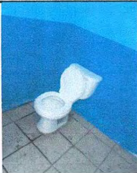
2.5 Suministro de accesorios a tazas sanitarias
