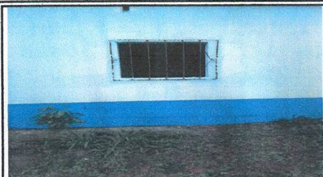
4.2 Suministro de ventanas
