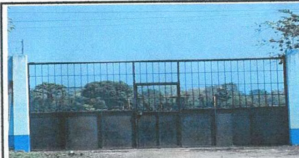
5.2 Suministro de laminas mas estructura metálica de soporte para cubierta de portón.
