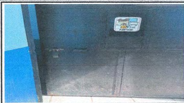
1.1 Mantenimiento de puertas
