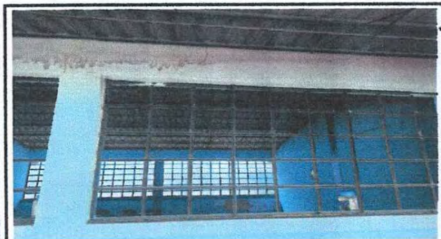
1.2 Mantenimiento de balcones
