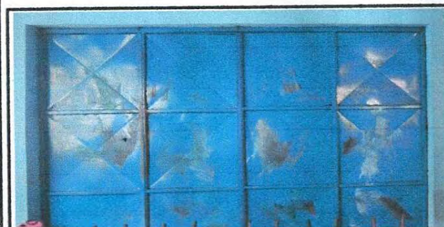
5.1 Mantenimiento de portón
