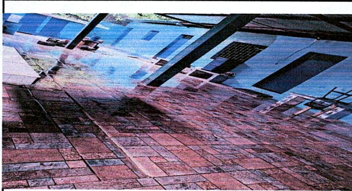
Foto1: Mantenimiento a estructura de metal (lijado aplicación de dos manos de pintura azul anticorrosiva)
