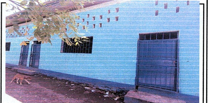
Foto 6: Sustitucion de puertas de metal por puerta de metal
