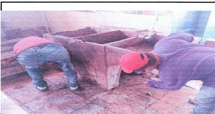
Foto 5: Sustitución de pila de concreto en cocina
