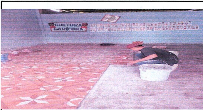
Foto 3: Sustitución de piso de concreto por piso ceramico en aulas
