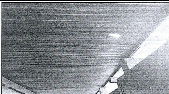
Foto 2: sustitucion de lamina , por lamina acanalada aluzinc calibre 26
