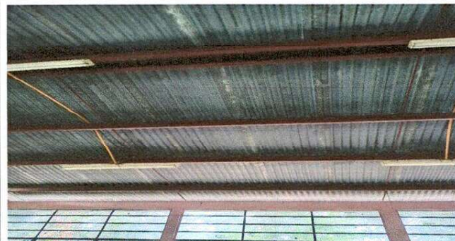
Foto 4: Mantenimiento de estructura de soporte de metal
