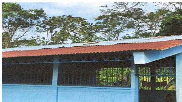
Foto 1: Sustrución de cubierta de lámina
