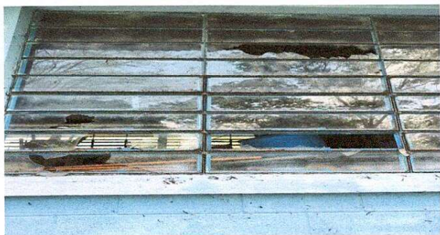
Foto 5. Mantenimiento de ventanas tipo balacín
