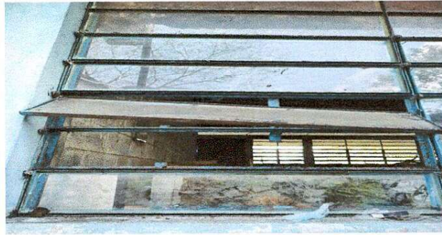
Foto 6: Mantenimiento de ventanas tipo balacín
