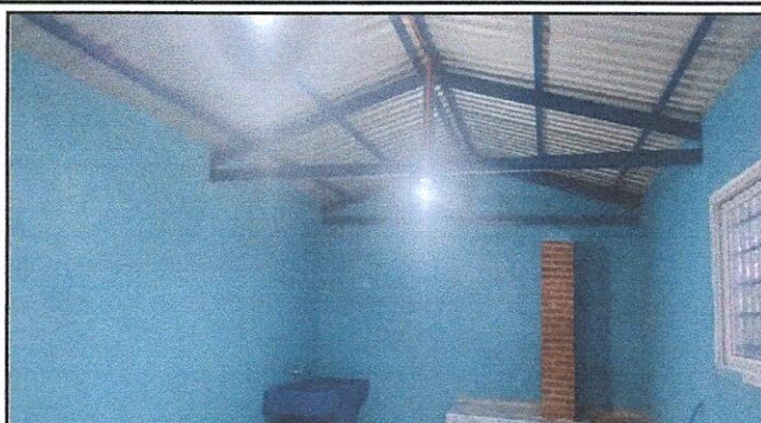
FOTO 2: Suministro de estructura de techo de metal
