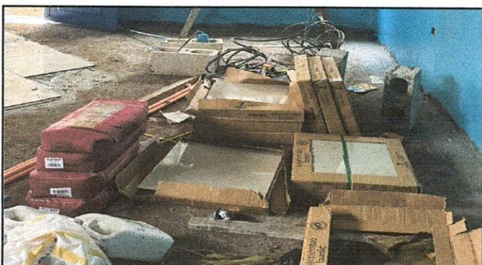
FOTO 3: Sustitución de piso de torta de concreto por piso cerámico
