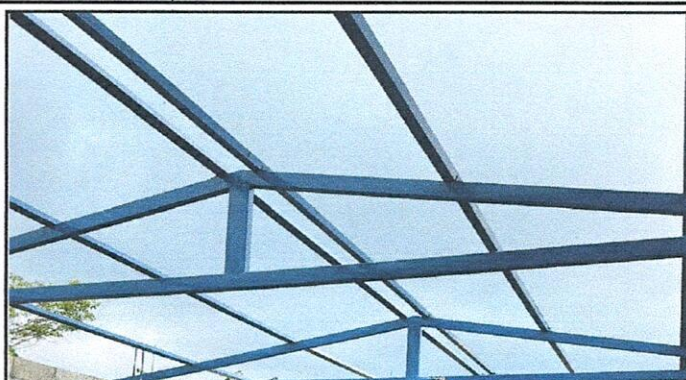
FOTO 2: Suministro de estructura de techo de metal
