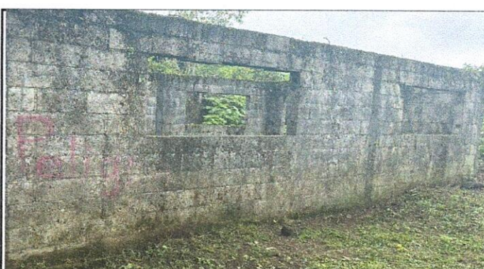
FOTO 4: Aplicación de repello y cernido en muros de cocina interior y exterior
