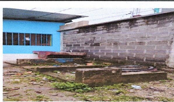
FOTO 2 RENGLO 1.3 SUMINISTRO DE LEVANTADO DE MURO DE BLOK EN SANITARIOS
