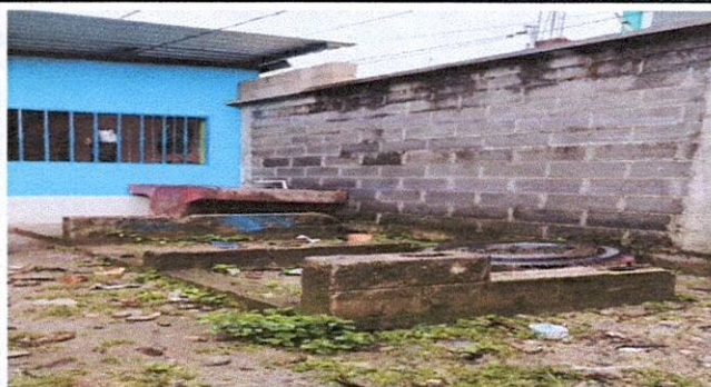
FOTO 1 RENGLO 1.1, 1,2 SUMINISTRO DE SANITARIOS, MINGITORIO.
