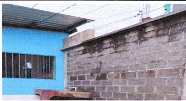
FOTO 3 RENGLO 1.4 SUMINISTRO E INSTALACION DE LAVAMANOS FUNDIDOS AZULEJEADOS
