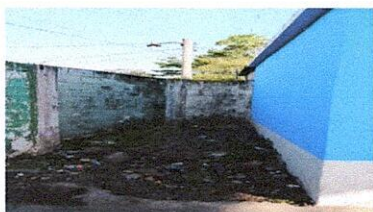
FOTO 9: REFERENCIA RENGLON 2.3 SUMINISTRO DE ESTRUCTURA METALICA TECHADO,FRENTE A CANCHA
