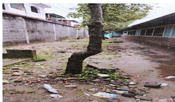
FOTO 4 RENGLO 1.6 SUMINISTRO DE FUNDICION DE TORTA DE CEMENTO Y PISO CERAMICO,
