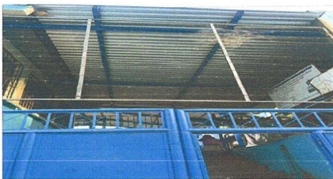
Foto 5: SUSTITUCIÓN DE BALCON DE METAL
