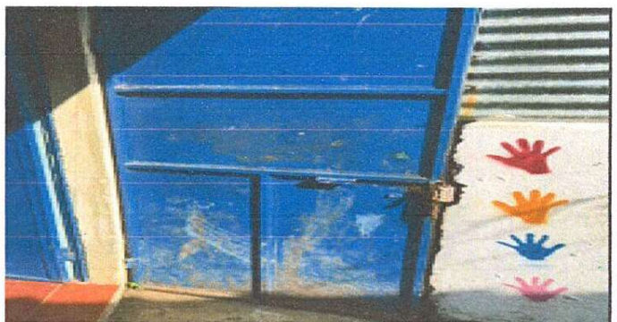
Foto 6: SUSTITUCIÓN DE PUERTA
