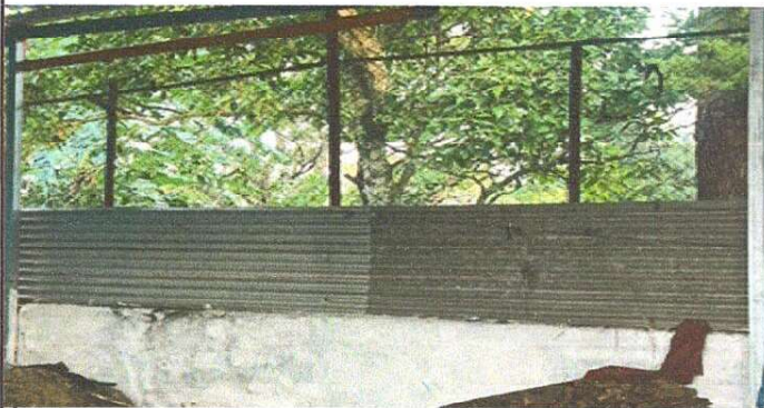
Foto 3: CONTINUACIÓN DE LEVANTADO DE MURO PERIMETRAL
