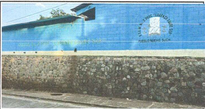
Foto 1: PINTURA MURO INTERIOR Y EXTERIOR
