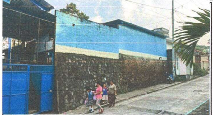
Foto 2: MANTENIMIENTO DE PORTON DE METAL
