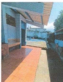
Foto 3: Referencia renglón 2.1 ( suministro de canal de metal + bajada de agua pluvial de pvc de 3")
