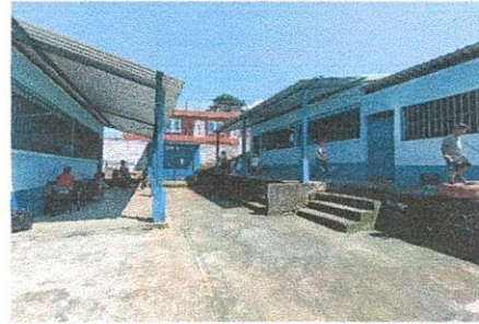
Foto 10: Referencia renglón 3.6 (suministro de pasamanos de metal, en gradas existentes).
