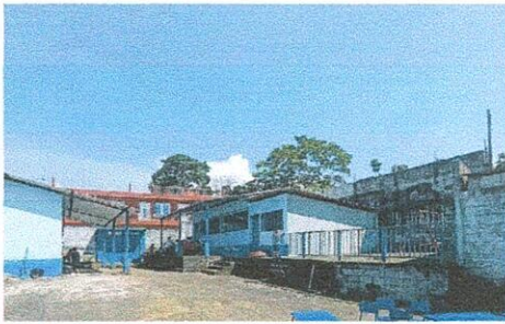
Foto 9: Referencia renglón 3.5 (suministro de baranda de metal).
