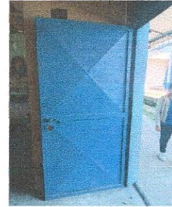
Foto 8: Referencia renglón 3.4 (reparación de puertas de metal, lijado, cepillado y pintura, incluye mano de obra).
