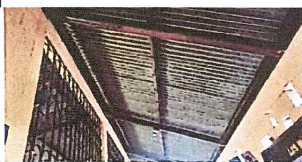
Foto 2: Sustrución de Lámina y costanera de los corredores
