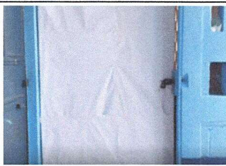
Foto 6: Reparación de portón y sustrución de puerta
