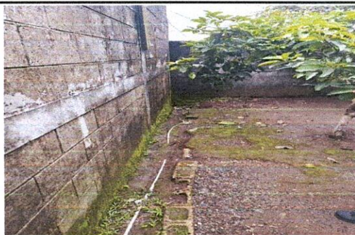
Foto 2: Referencia renglón 1.6 (repello y cernido muro perimetral)
