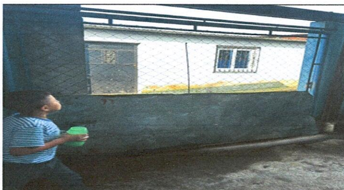
Foto 4: Sustitución de portón
