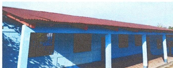
FOTO 2: Sustitución de lámina, por lámina troquelada aluzinc calibre 26
