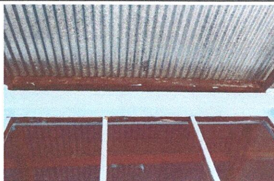
FOTO 4: Sustitución de estructura de madera, por estructura portante de metal
