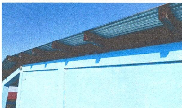
FOTO 5: Sustitución de estructura de madera, por estructura portante de metal
