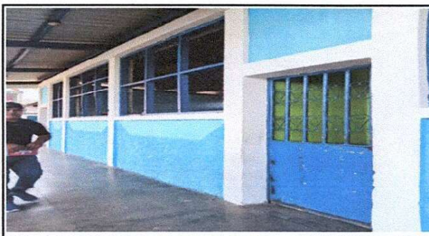
Foto 6: SUSTITUCIÓN DE BALCONES DE MADERA CON MAYA METALICA POR BALCON DE METAL
