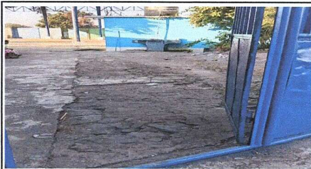
Foto 3: REPARACIÓN A LOSA DE PATIO DE IN GRESO PRINCIPAL DEL ESTABLECIMIENTO
