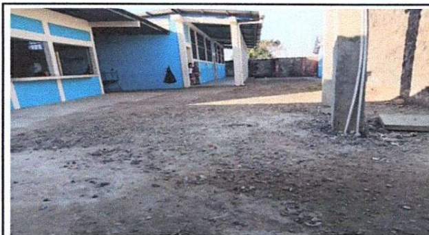
Foto 4: REPARACION DE LOSA DE PATIO DE COCINA Y SERVICIOS SANITARIOS
