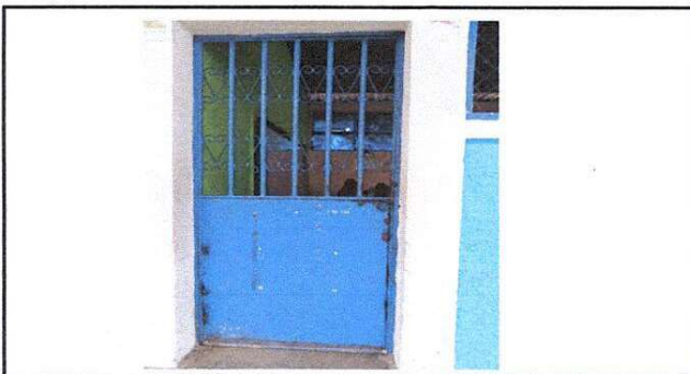
Foto 5: SUSTITUCIÓN DE PUERTAS DE METAL POR PUERTAS DE METAL DE 2.10 X 1.00
