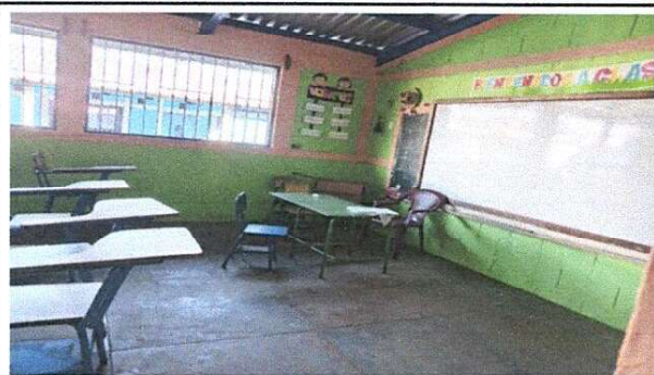
Foto1: SUSTITUCIÓN DE PISO DE CEMENTO POR PISO CERAMICO
