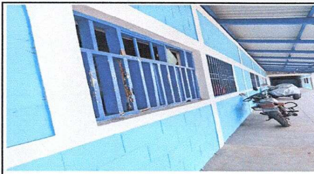
Foto 2: SUSTITUCIÓN DE BALCONES DE MADERA CON MAYA EXIASTENTE DE METAL POR BALCONES DE METAL
