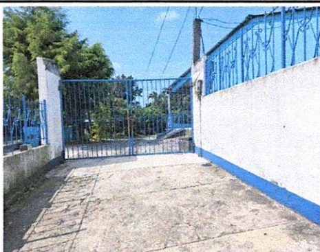
FOTO 3: Sustrucción de estructura, por estructura portante de metal sobre portón
