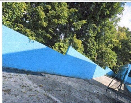
FOTO 2: Suministro de levantado en muro perimetral h: 0.60 (incluye columnas y soleras)
