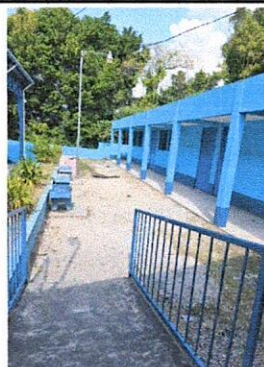
FOTO 4: Sustrucción de losa de patio de concreto t: 0.10 + Suministro de lámina, por lámina troquelada aluzinc calibre 26
