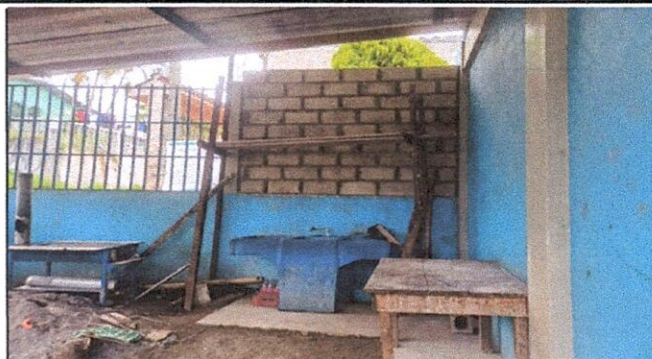
Foto 2: Sustitución de baranda de metal existente por continuación de muro de block
