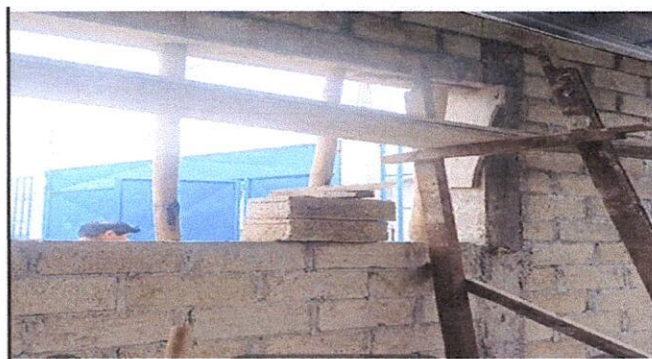
FOTO 4: Apliación de repello y cernido en muros de cocina
