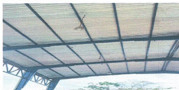
FOTO 2: Reparación de sistema eléctrico de iluminación (10 luminarias, cableado, 4 interruptores)
