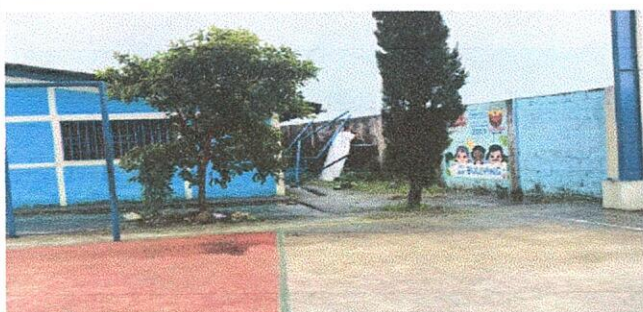
FOTO 3: Suministro de barandal de metal de 4.00 x 3.00 metros
