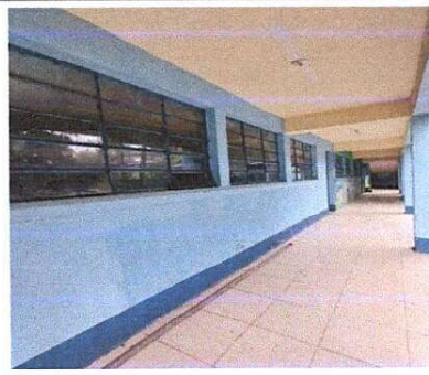
Foto 4: sustitución de ventanas de metal por ventanas PVC
