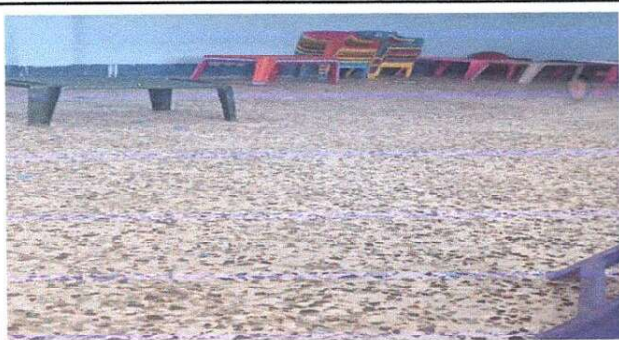
Foto 3: Sustrucción de piso de granito por piso antideslizante aula
