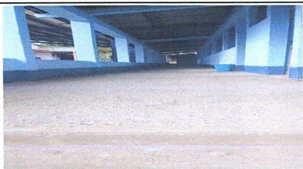
Foto 1: Sustrucción de piso de granito por piso antideslizante corredor
