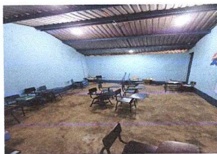
Foto 5: Reparación de Sistema eléctrico
