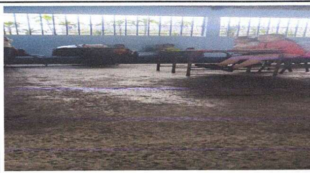
Foto 2: Sustrucción de piso de granito por piso antideslizante en aula
