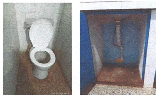
Foto 6: Sutiución de sanitario por sanitario, Sustitución de kit de accesorios en sanitario
