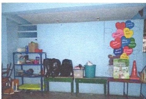
Foto 3: Suministro de block tabique para división de aula (incluye columnas de 0.10 x 0.15mt con hierro Ø 1/2" est. 1/4 + solera de 0.20 x 0.10 con hierro Ø 3/8" est. 1/4")
