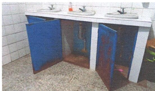
Foto 5: mantenimiento a mezon de lavamanos 1.50 x 0.60 incluye suministro de 2 puertas de metal 0.60 x 0.40, kit de accesorio y llave
