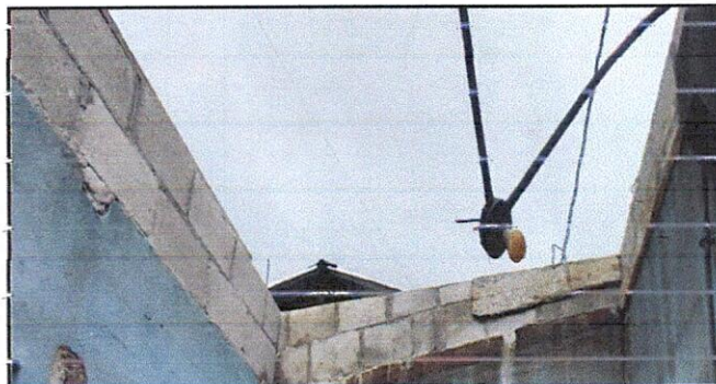
Foto 4: Se realizará la instalación de cubierta de lámina troquelada Aluzinc calibre 26
