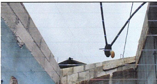
Foto 3: Se realizará la instalación de estructura de techo en cocina
