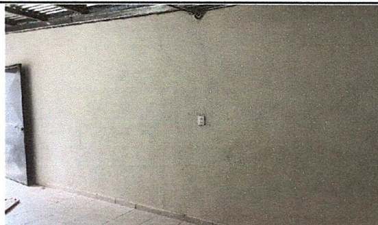
Foto 2: Suministro de repello de muro
