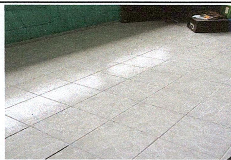
Foto 11: Suministro de piso cerámico
