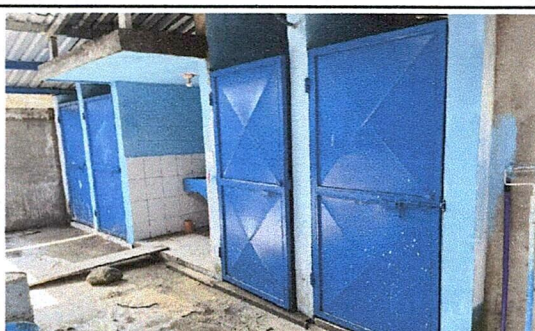
Foto 4: Mantenimiento de puertas de metal de 0.90 x 2.00
