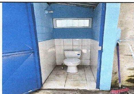
Foto 5: Sustitución de sanitarios con sus accesorios
