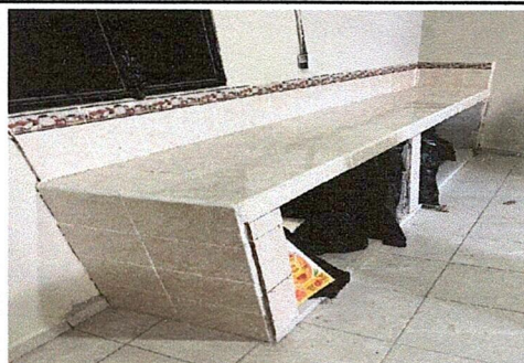
Foto1: Suministro de azulejo para gabinetes de cocina
