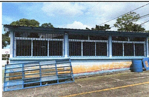
Foto 10: Suministro de ventanas pvc de 1.60 x 2.70 metros
