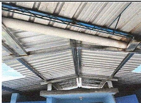
Foto 8: Suministro de lámina troquelada aluzinc calibre 26 + estructura de techo
