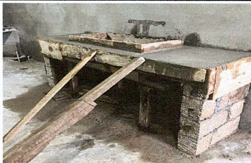
Foto 3: Suministro de lavatrastos de concreto + revestimiento de azulejo 0.60 x 2.20
