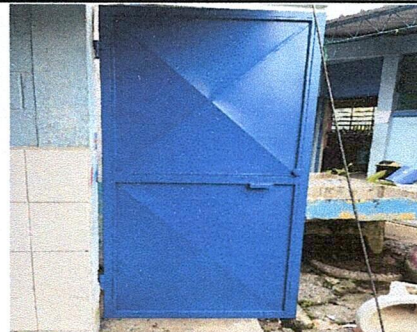
Foto 4: Mantenimiento de puertas de metal de 0.90 x 2.00
