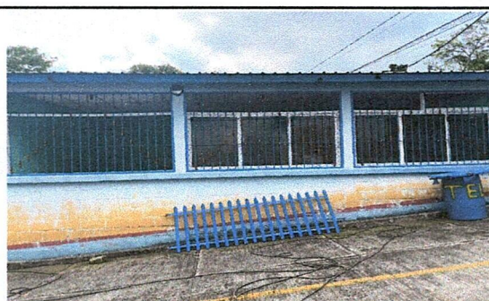
Foto 10: Suministro de ventanas pvc de 1.60 x 2.70 metros
