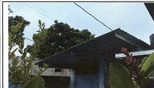
Foto 7: Suministro de lámina troquelada aluzinc calibre 26 + estructura de techo
