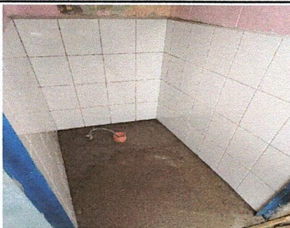
Foto 5: Sustitución de sanitarios con sus accesorios
