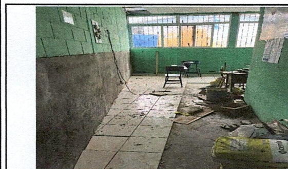
Foto 11: Suministro de piso cerámico
