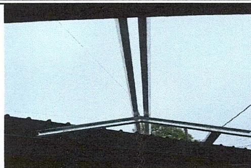
Foto 8: Suministro de lámina troquelada aluzinc calibre 26 + estructura de techo
