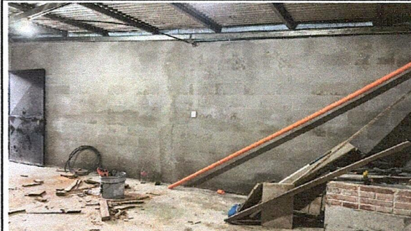
Foto 2: Suministro de repello de muro
