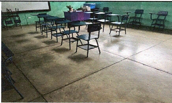
Foto 9: Suministro de piso cerámico
