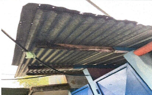
Foto 7: Suministro de lámina troquelada aluzinc calibre 26 + estructura de techo
