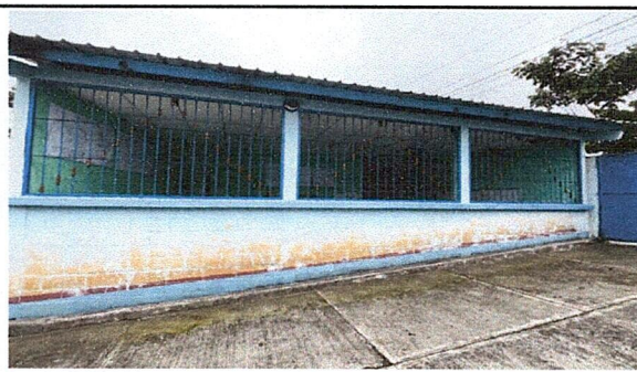
Foto 10: Suministro de ventanas pvc de 1.60 x 2.70 metros
