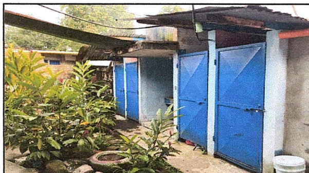
Foto 4: Mantenimiento de puertas de metal de 0.90 x 2.00
