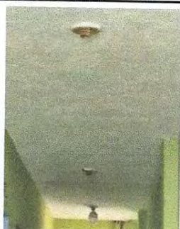
Cambio de plafonera y focos
