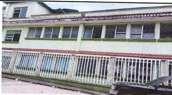
Sustitución de ventana de paleta con pvc con vidrio
