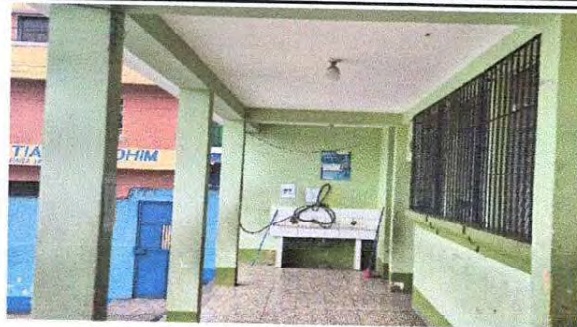
Cambio de azulejos a lavamanos en primer nivel
