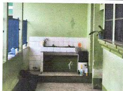
Cambio de azulejos a lavamanos en el segundo nivel
