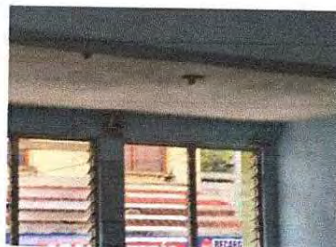
Cambio de ventana de paleta de vidrio a ventana pvc y cambio de plafoneras con foco.
