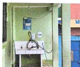
Cambio de azulejo a lavamanos
