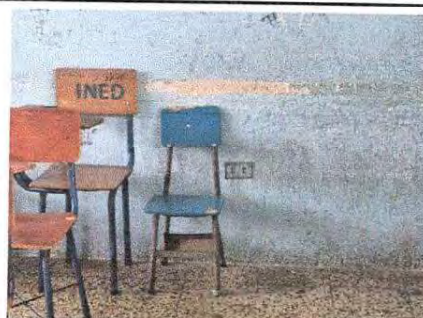
cambio de tomacorrientes
