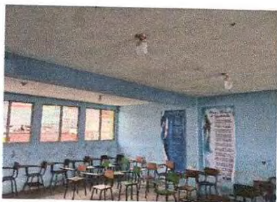
Cambio de focos de salon de segundo nivel
