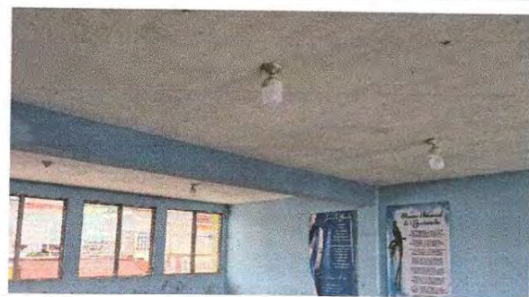
Sustitución de ventana de paleta con pvc con vidrio
