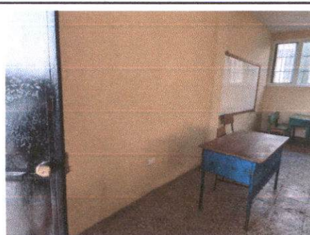
Foto 2: Cambio de Chapas y Pintura de Puertas en el primer y segundo nivel
