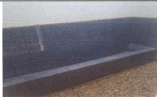
Foto 4: Cambio de azulejo en mingitorio primer y segundo nivel
