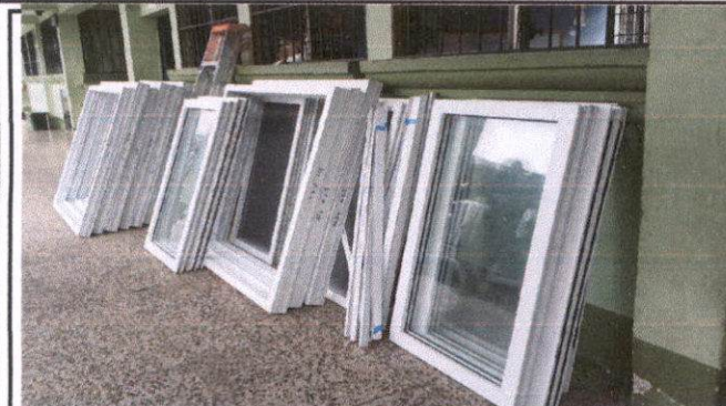
Foto1: Cambio de ventanas de aluminio por PVC.
