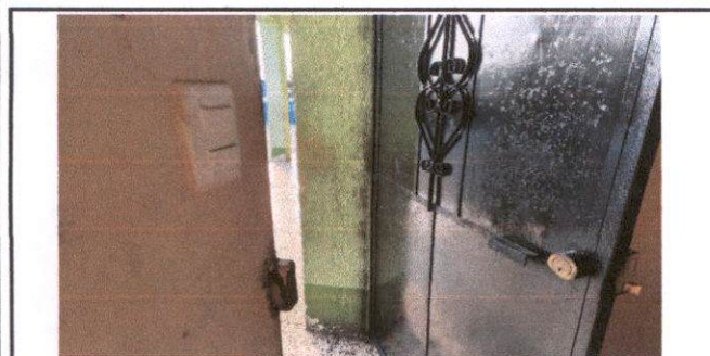
Foto 3: Cambio de chapas y pintura en puertas de cada salon de clase, primer y segundo nivel.
