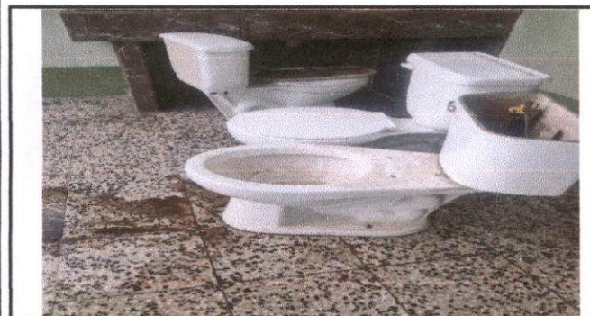
Foto 5: Cambio de sanitarios
