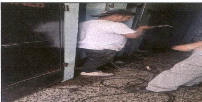
Foto 4: Cambio de puertas de sanitarios
