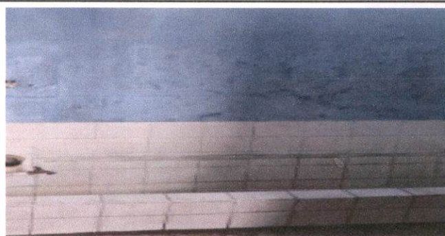
Foto 4: Sustitución de azulejo de mingitorios
