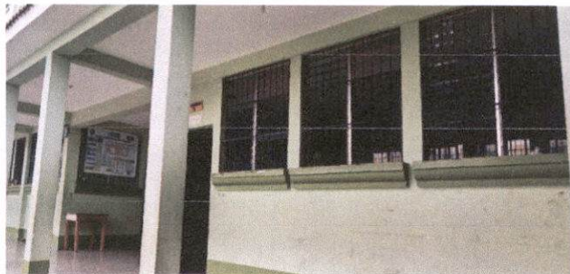
Foto1: Sustitución de ventanas de aluminio por PVC interno, aplicación de pintura en muros interiores y exteriores
