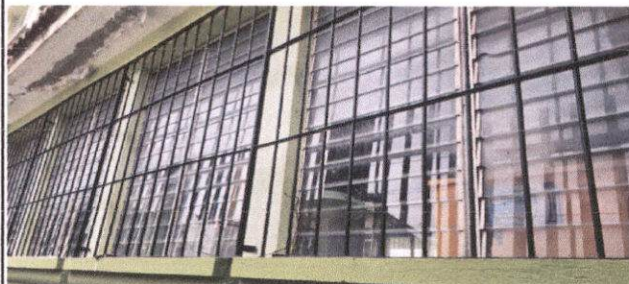
Foto 2: Sustitución de ventanas de aluminio por PVC externo
