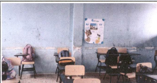
Foto 5: Reparación de repello en paredes
