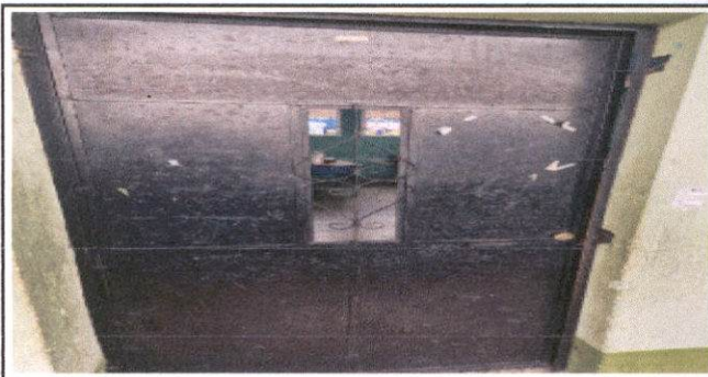
Foto 6: Sustitución de puertas de metal
