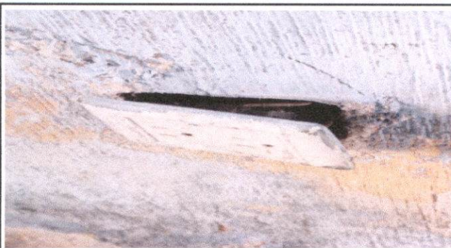
Foto 3: Sustitución de tomacorrientes
