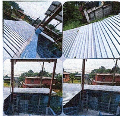
Foto 2: Suministro de lámina troquelada calibre 26 + estructura de soporte de metal (en áreas de pasillos, ingreso principal y patio)
