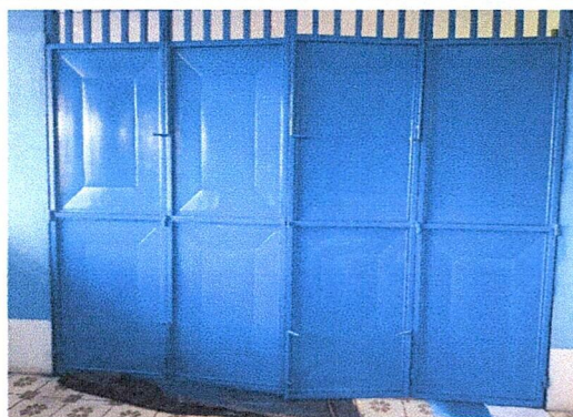
Foto 10: Mantenimiento de portones de metal de 3.55 x 2.82 de módulo de aulas (cepillado, lijado con 2 manos de pintura anticorrosiva)
