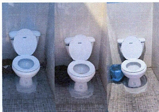
Foto 5: Suministro de inodoros de porcelana
