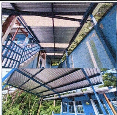
Foto 3: Suministro de canal de metal + bajadas de agua pluvial pvc 3''
