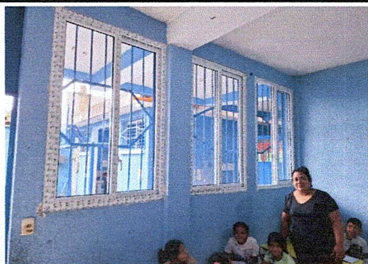
Foto 11: Suministro de ventanas corredizas pvc blanco
