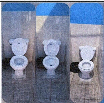
Foto 9: Suministro de inodoros de porcelana
