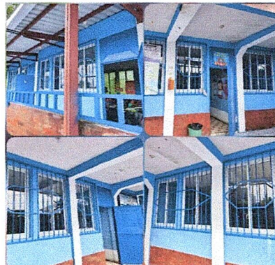
Foto 8: Suministro de ventanas corredizas pvc blanco
