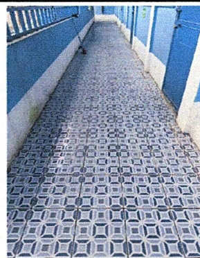
Foto 12: Suministro de piso antideslizante en módulo de pasillo frente a aulas
