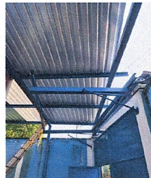
Foto 16: Suministro de lámina troquelada calibre 26 + estructura de soporte de metal"
