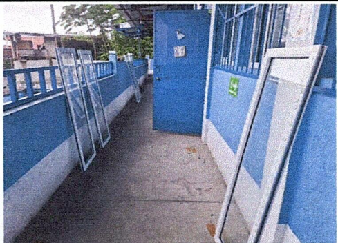
Foto 7: Suministro de ventanas corredizas pvc blanco
