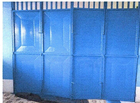
Foto 2: Mantenimiento de portones de metal de 3.55 x 2.85 de módulo de aulas (cepillado, lijado con 2 manos de pintura anticorrosiva)
