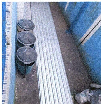
Foto 15: Suministro de lámina troquelada calibre 26 + estructura de soporte de metal
