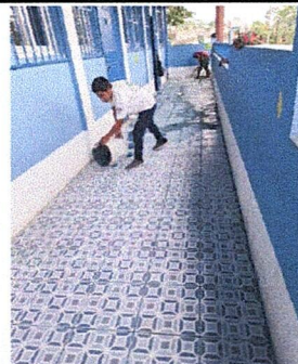
Foto 6: Suministro de piso antideslizante en módulo de pasillo frente aulas
