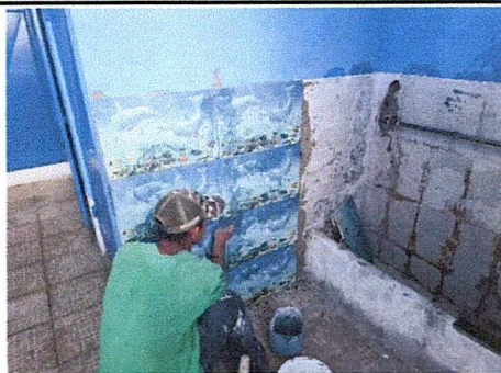
Foto 12: Suministro de azulejos en módulos de baños
