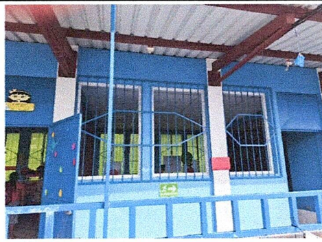
Foto 8: Suministro de ventanas corredizas pvc blanco
