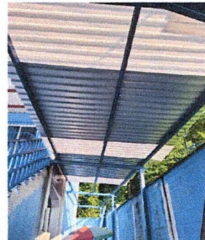
Foto 14: Suministro de lámina troquelada calibre 26+ estructura de soporte de metal (en áreas de pasillos, ingreso principal y patio)
