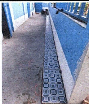
Foto 5: Suministro de piso antideslizante en módulo de pasillo frente aulas
