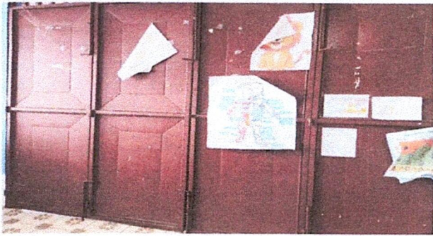
Foto 1: Mantenimiento de portones de metal de 3.55 x 2.85 de módulo de aulas (cepillado, lijado con 2 manos de pintura anticorrosiva)
