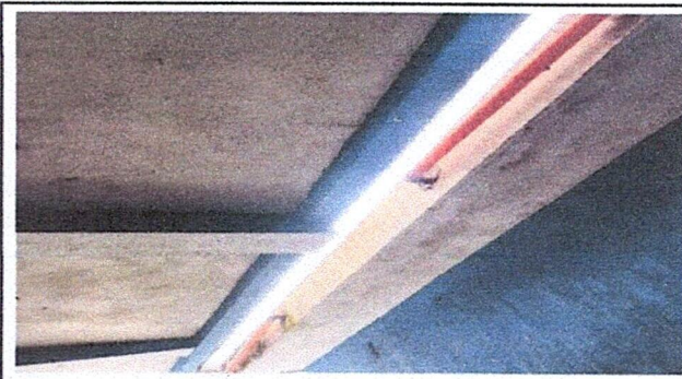
Foto 4: Mantenimiento de canal de metal + bajadas de agua pluvial pvc 3"
