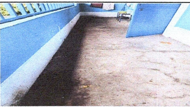
Foto 5: Suministro de piso antideslizante en módulo de pasillo frente aulas
