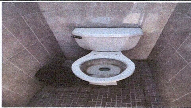
Foto 3: Suministro de inodoros de porcelana
