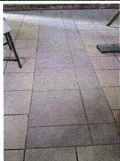
Foto 5: Sustitución de piso por piso cerámico
