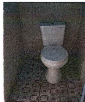
Foto 4: Sustitución de inodoro por inodoro
