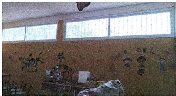
Foto 1: Suministro e instalación de ventana U-PVC blanco con vidrio 5mm, sustitución de piso por piso cerámico
