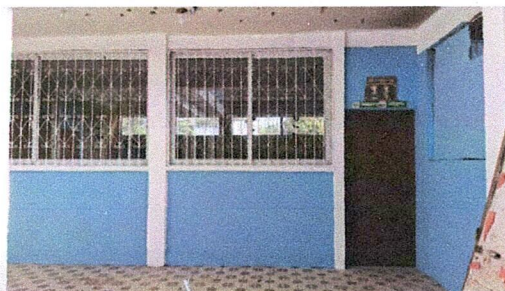
Foto 6: Suministro e instalación de ventana U-PVC blanco con vidrio 5mm
