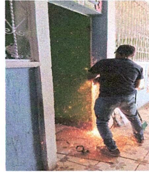
Foto 2: sustitución de puerta de metal por puerta de metal 0.90 x 2.10
