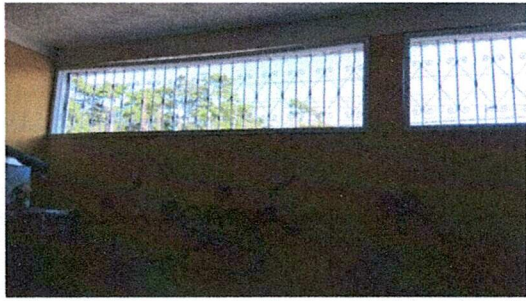
Foto 1: Suministro e instalación de ventana U-PVC blanco co vidrio 5 mm, sustitución de piso por piso ceramico
