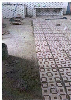
Foto 3: Suministro de pila 1.80 x 0.90 x 0.80, suministro de lava manos incluye accesorios y grifo, sustitución torta de concreto por piso ceramico
