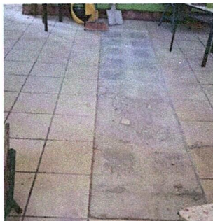
Foto 5: Sustitución de piso por piso ceramico
