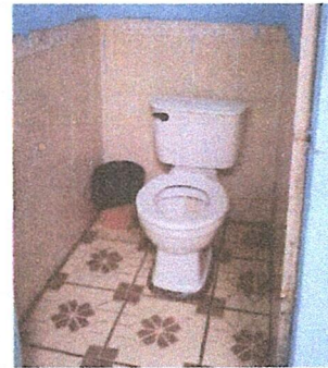
Foto 4: Sustitución de inodoro por inodoro
