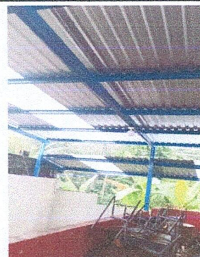
Foto 16: Estructura de Techo
