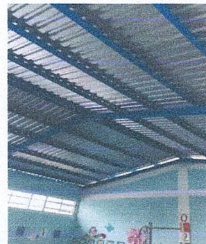
Foto 6: Cambio de Laminas Modulo Aula
