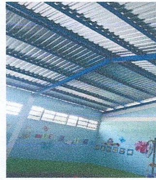
Foto 2: Cambio de Laminas Modulo Aula
