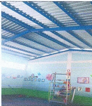
Foto 5: Cambio de Laminas Modulo Aula
