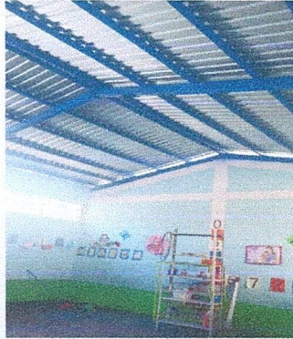
Foto 1: Cambio de Laminas Modulo Aula
