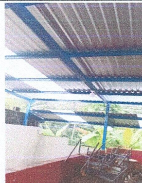
Foto 14: Estructuta de Techo
