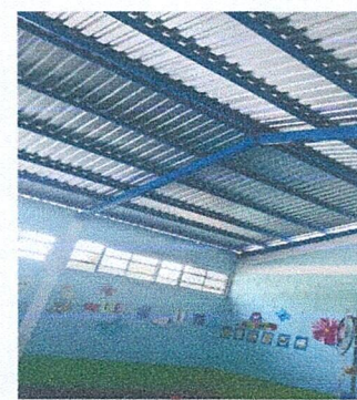
Foto 4: Cambio de Laminas Modulo Aula
