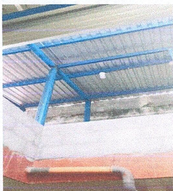
Foto 15: Estructura de Techo
