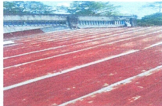
Foto 10: Cambio de laminas, modulo aula.
