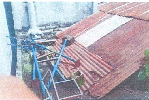
Foto 9: Cambio de laminas, modulo aula.
