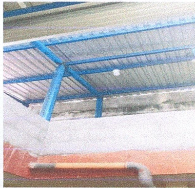
Foto 15: Estructura de Techo
