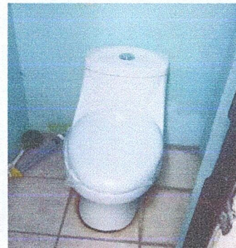
Foto 18: Remodelacion de Sanitarios
