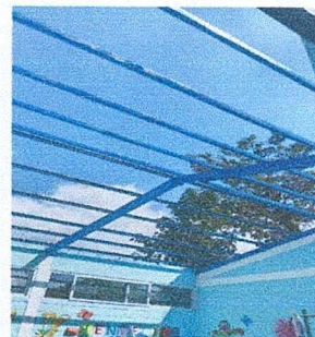
Foto 6: Cambio de Laminas Modulo Aula
