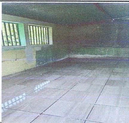
Foto 7: Sustrucción de piso cerámico de aula
