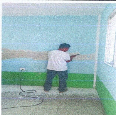
Foto 11: Reparación y Sernido de Paredes
