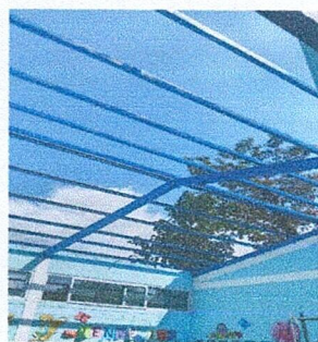
Foto 5: Cambio de Laminas Modulo Aula
