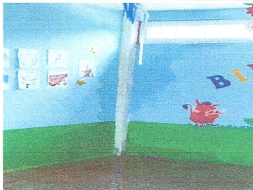
Foto 16: Reparación de sernido de paredes.
