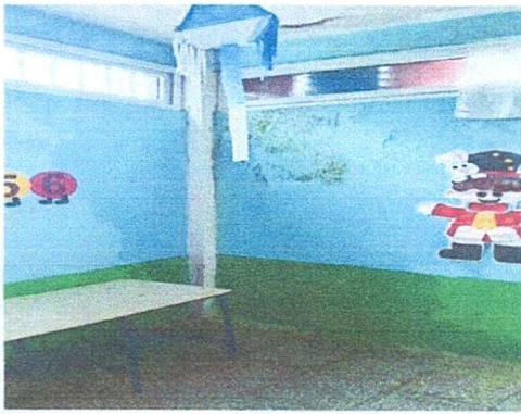
Foto 15: Reparación de sernido de paredes.
