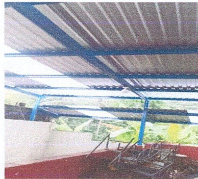
Foto 16: Estructura de Techo
