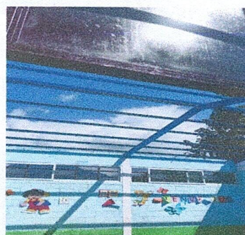
Foto 3: Cambio de Laminas Modulo Aula
