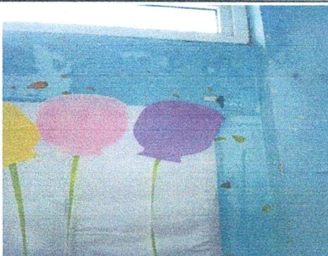
Foto 18: Reparación de sernido de paredes.
