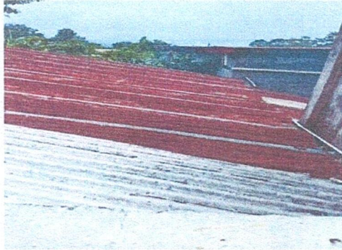
Foto 7: Cambio de laminas, modulo aula.
