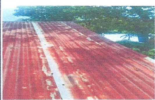
Foto 12: Cambio de laminas, modulo aula.
