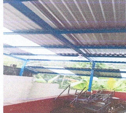
Foto 14: Estructura de Techo
