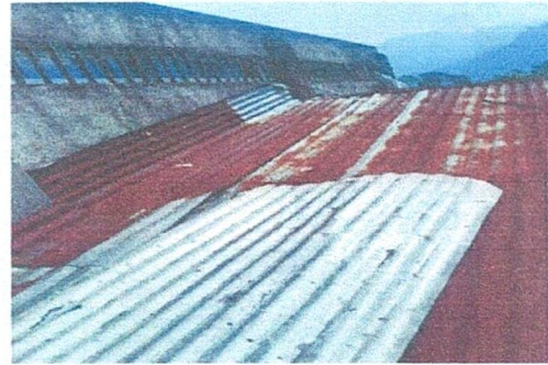
Foto 8: Cambio de laminas, modulo aula.
