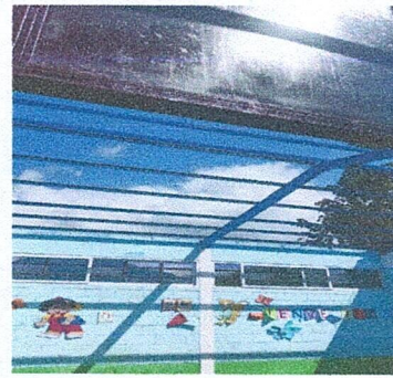
Foto 2: Cambio de Laminas Modulo Aula
