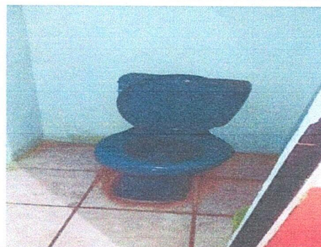
Foto 6: Sustitución de sanitario.
