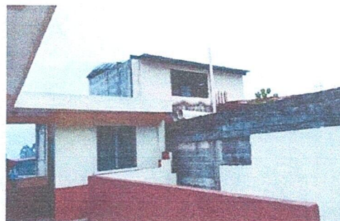
Foto 4: Estructura de techo.
