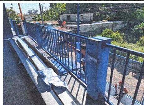
Foto 4: Mantenimiento de 35 metros lineales de baranda principal, (lijado, cepillado con 2 manos de pintura anticorrosiva).
