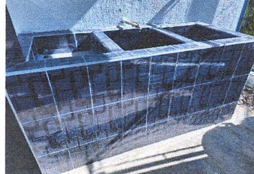
Foto 10: Mantenimiento 10 metros cuadrados de pila de concreto con instalación de azulejos.
