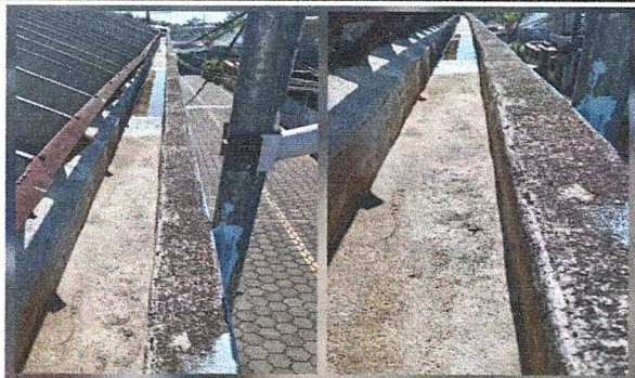
Foto 3: Reparación de canal de concreto agua fluvial colocándole impermealizante.
