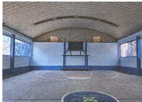
Foto 12: Pintura de 501 metros cuadrados en paredes interiores de aulas y exteriores de salones de clases, pasillos, pared de calle e interior, cancha escolar.
