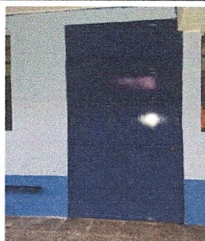
Foto 5: Mantenimiento de 11 puertas principales de aulas, 1.80 x 1.00 (lijado, cepillado con 2 manos de pintura anticorrosiva)
