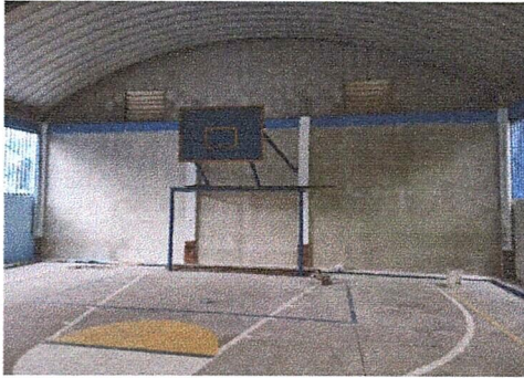
Foto 7: Mantenimiento de cernido y repello de pared 92 metros cuadrados, modulo de cancha escolar y calle.
