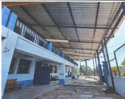
Foto1: Suministro de 98 metros cuadrados de lámina troquelada calibre 26, más estructura de metal, en área de pasillo, ingreso y egreso del establecimiento.
