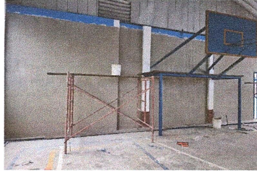
Foto 8: Mantenimiento de cernido y repello de pared 92 metros cuadrados, modulo de cancha escolar y calle.
