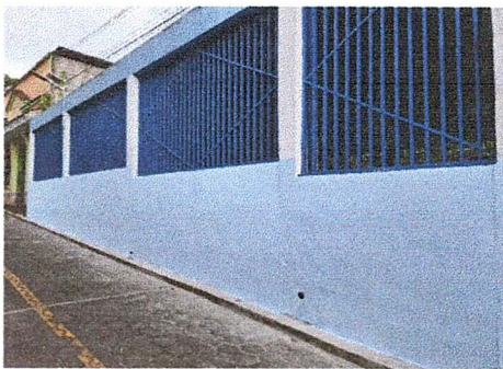
Foto 11: Pintura de 501 metros cuadrados en paredes interiores de aulas y exteriores de salones de clases, pasillos, pared de calle e interior, cancha escolar.
