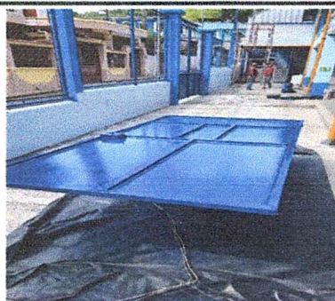
Foto 7: Mantenimiento de 11 puertas principales de aulas, 1.80 x 1.00 (lijado, cepillado con 2 manos de pintura anticorrosiva)
