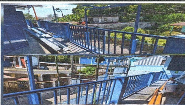
Foto 4: Mantenimiento de 35 metros lineales de baranda principal, (lijado, cepillado con 2 manos de pintura anticorrosiva).
