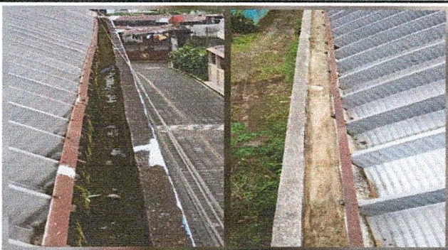
Foto 3: Reparación de canal de concreto agua fluvial colocándole impermealizante.
