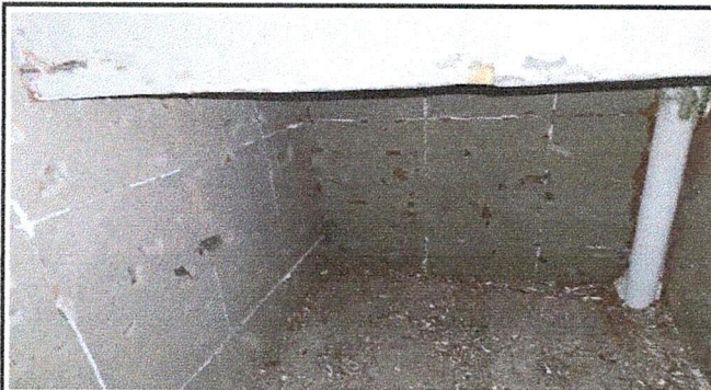
Foto 9: Mantenimiento 10 metros cuadrados de pila de concreto con instalación de azulejos.
