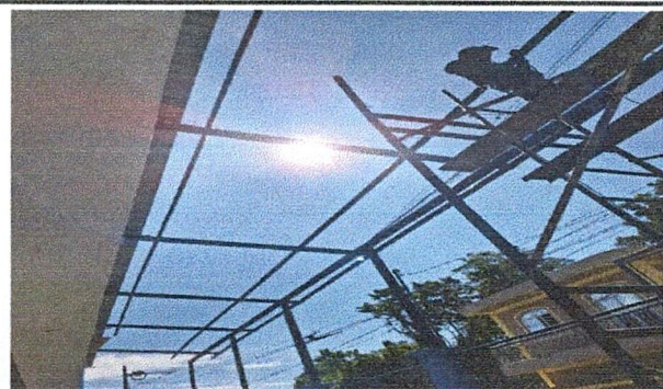
Foto1: Suministro de 98 metros cuadrados de lámina troquelada calibre 26, más estructura de metal, en área de pasillo, ingreso y egreso del establecimiento.
