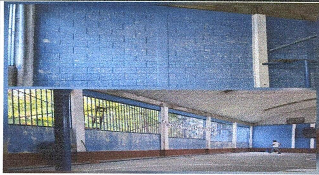
Foto 7: Mantenimiento de cernido y repello de pared 92 metros cuadrados, modulo de cancha escolar y calle.
