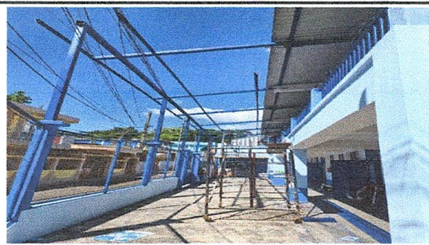
Foto2: Suministro de 98 metros cuadrados de lámina troquelada calibre 26, más estructura de metal, en área de pasillo, ingreso y egreso del establecimiento.
