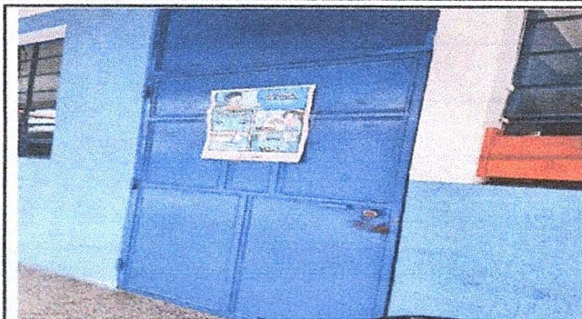
Foto 7: Servicio de mantenimiento de 11 puertas de aulas (lijado, cepillado con 2 manos de pintura anticorrosiva) 2.60 x 1.00
