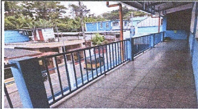
Foto 4: Servicio de mantenimiento de 35 metros lineales de baranda principal segundo nivel (lijado y cepillado con 2 manos de pintura anticorrosiva)
