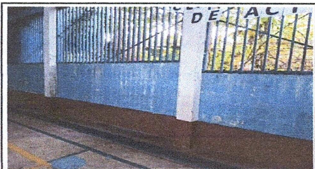
Foto 6: Servicio de mantenimiento de cernido y repello de pared modulo de cancha escolar y pared exterior calle 92 metros cuadrados
