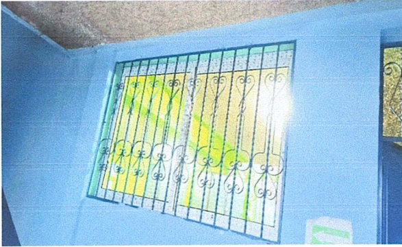
Foto 1: Suministro de ventana pvc corrediza vidrios claros
