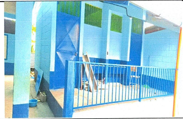
Foto 4: Mantenimiento de puerta de metal de 1.00 x 2.20 (lijado, cepillado y aplicación de 2 manos de pintura anticorrosiva)
