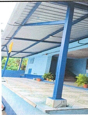
Foto 3: Mantenimiento de estructura portante de metal (lijado y cepillado y aplicación de 2 manos de pintura anticorrosiva) (incluye mano de obra)
