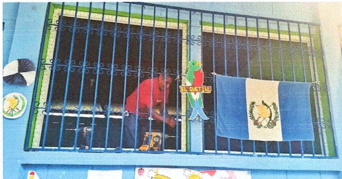
Foto 1: Suministro de ventana pvc corrediza vidrios claros
