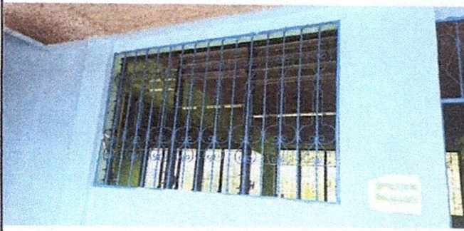
FOTO 1: Suministro de ventanas pvc corrediza vidrios claros
