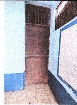
FOTO 2: Sustitución de puerta, por puerta de metal de 0.90 x 2.76 metros
