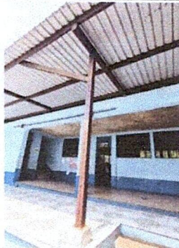
FOTO 3: Mantenimiento de estructura portante de metal (lijado, cepillado y aplicación de 2 manos de pintura anticorrosiva) (incluye mano de obra)
