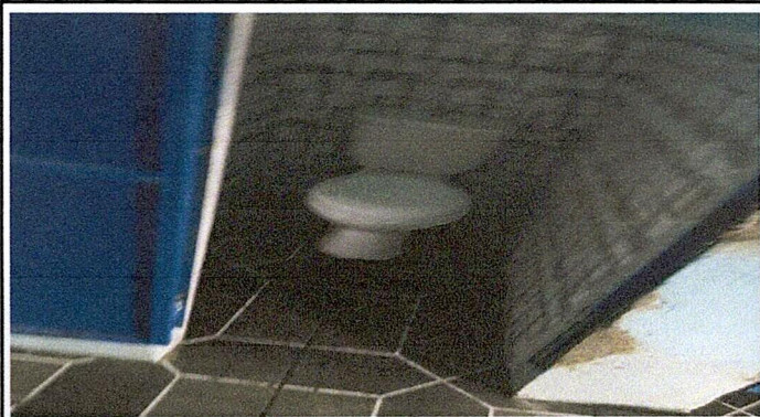
Foto 3: Sustitución de puerta de metal de 0.90 x 1.50, Sustitución de inodoro
