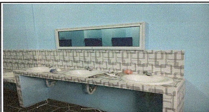
Foto 5: Suministro de mesa de concreto para lavamanos, Sustitución de lavamanos
