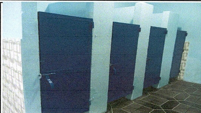
Foto 1: Sustitución de puerta de metal de 0.90 x 1.30
