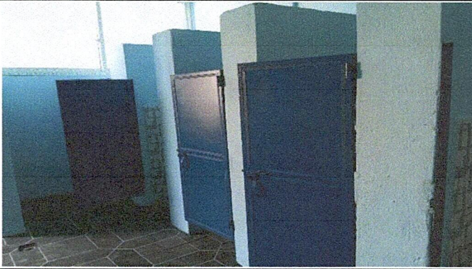
Foto 1: Sustrucción de puerta de metal de 0.90 x 1.30
