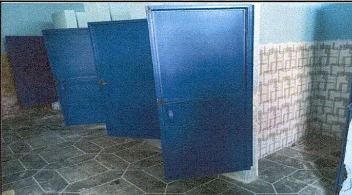
Foto 3: Sustrucción de puerta de metal de 0.90 x 1.50, Sustrucción de inodoro
