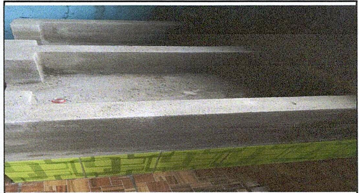
Foto 4: Sustrucción de estufa rural (completa) incluye chimenea y plancha de metal de 1.10 x 1.10
