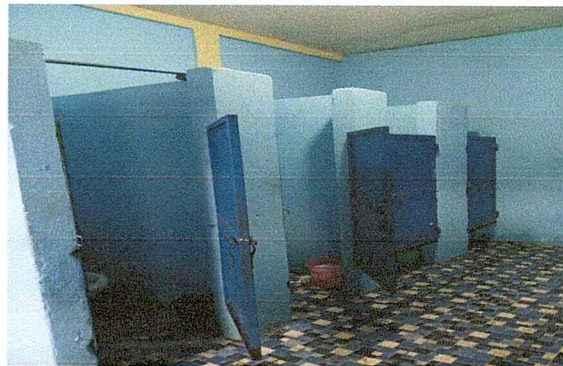
Foto 1: Sustitución de puerta de metal de 0.90 x 1.30
