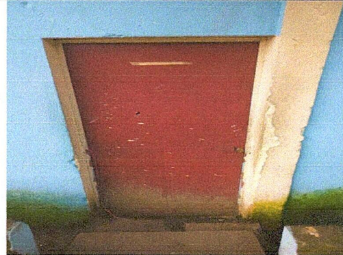
Foto 2: Sustitución de puerta de metal de 1.00 x 2.10
