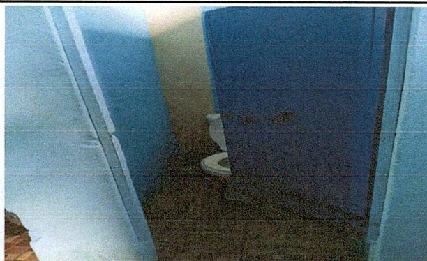
Foto 3: Sustitución de puerta de metal de 0.90 x 1.50, Sustitución de inodoro
