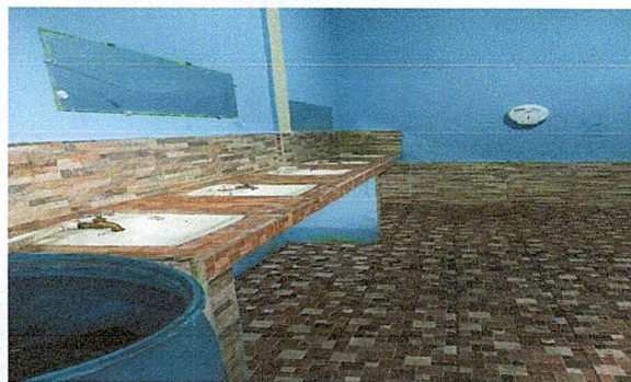
Foto 5: Suministro de mesa de concreto para lavamanos, Sustitución de lavamanos
