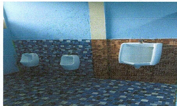
Foto 6: Suministro de azulejo en muros interiores de servicio sanitario, Sustitución de piso por piso cerámico
