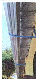
FOTO 6: Suministro de canales de metal + bajadas pluvial pvc 3"
