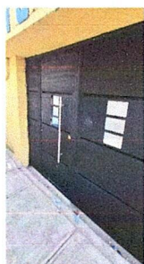
FOTO 1: Sustrucción de Portón metal de ingreso principal de 2.00 x 2.50
