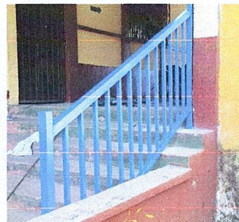
FOTO 4: Suministro de pasamanos de metal h: 1.000
