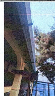
FOTO 6: Suministro de canales de metal + bajadas pluvial pvc 3"
