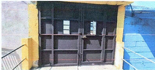
FOTO 1: Sustitución de portón de metal de ingreso principal de 2.00 x 2.50
